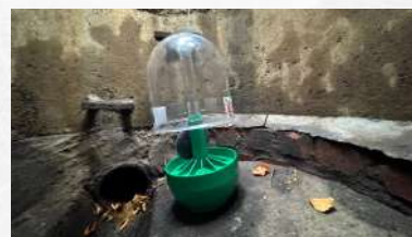
5. Rattenkugel am Seil in den Schacht absenken und auf der Berme abstellen.
