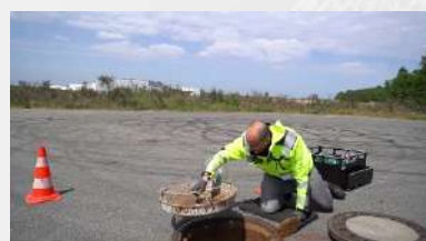
3. Schachtdeckel öffnen und Schmutzfänger entfernen.
