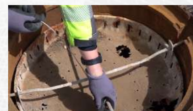
7. Jetzt das Seil durch das Seilschloss straffziehen bis das Gewicht der Rattenkugel zu spüren ist (Rattenkugel muss auf der Berme stehen bleiben). Das Seilschloss fixiert automatisch das Seil.
