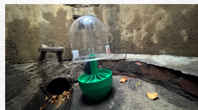
5. Rattenkugel am Seil in den Schacht absenken und auf der Berme abstellen.
