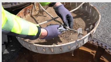
4. Seilschloss am Schmutzfänger oder an der zusätzlich erhältlichen Einhängestrebe befestigen.
