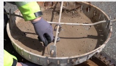
6. Das Seil von unten durch ein Loch des Schmutzfangs nach oben führen.
