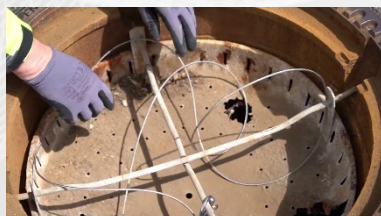
7. Das überschüssige Seil in den Schmutzfang legen.
