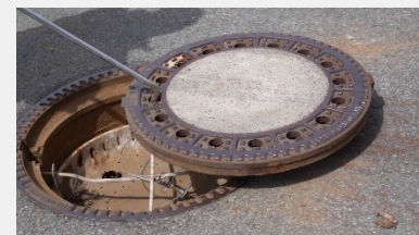
8. Schachtdeckel wieder verschließen, fertig!
