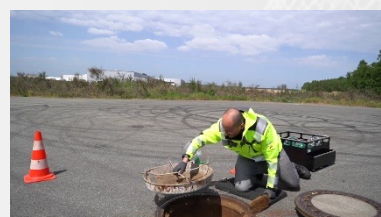
3. Schachtdeckel öffnen und Schmutzfänger entfernen.
